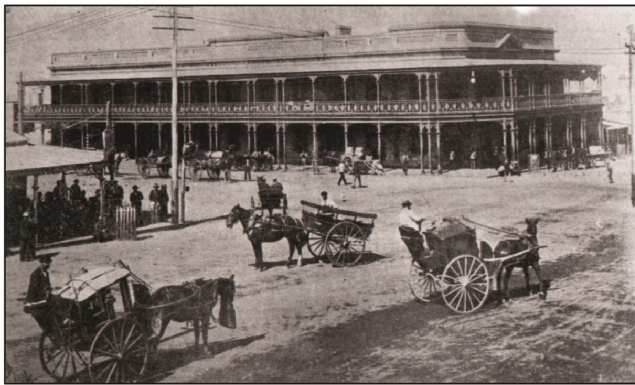
EG-N-006-003a, The Palace Hotel, Kalgoorlie
